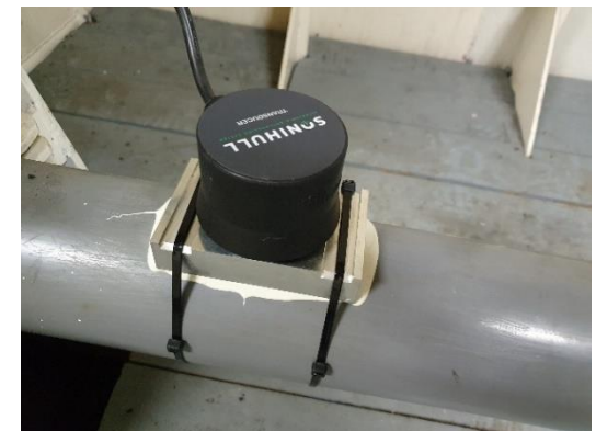
Transducer op een leiding m.b.v. een pipe adaptor
