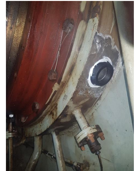
Verlijmde transducerring op stern tube bearing
